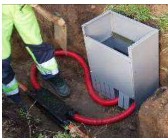
Рисунок 79: Распределение каналов кабельной канализации
