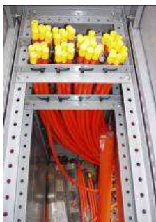
Рисунок 80: Ввод и крепление кабелей и каналов
