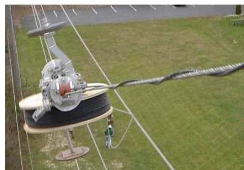
Рисунок 75: Навивка кабеля на грозотрос
