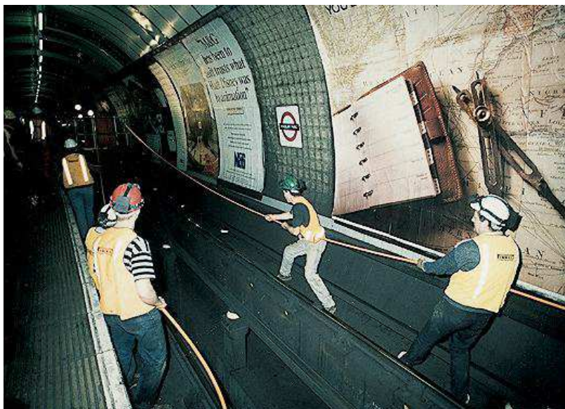
Рисунок 85: Прокладка кабеля в туннеле метрополитена
