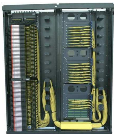
Рисунок 16: Оптический кросс высокой ёмкости
