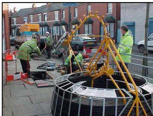
Рисунок 48: Прокладка кабеля в каналах кабельной канализации
