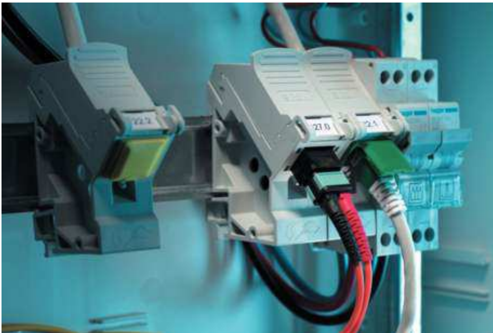
Рисунок 46: Модуль ОТО, установленный на DIN рейку вместе с электрическими выключателями
