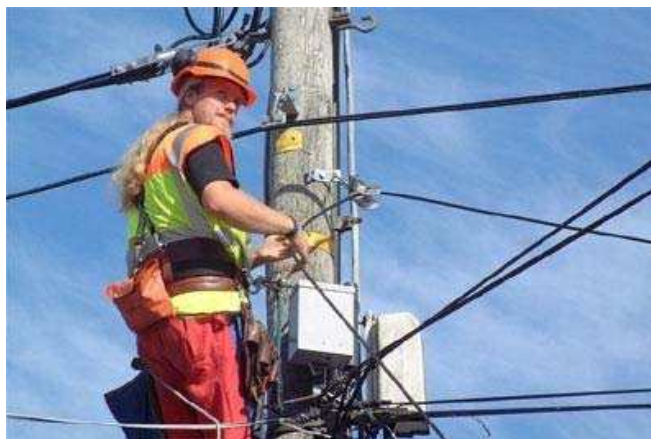
Рисунок 77: Прокладка кабеля воздушной ВОЛС
