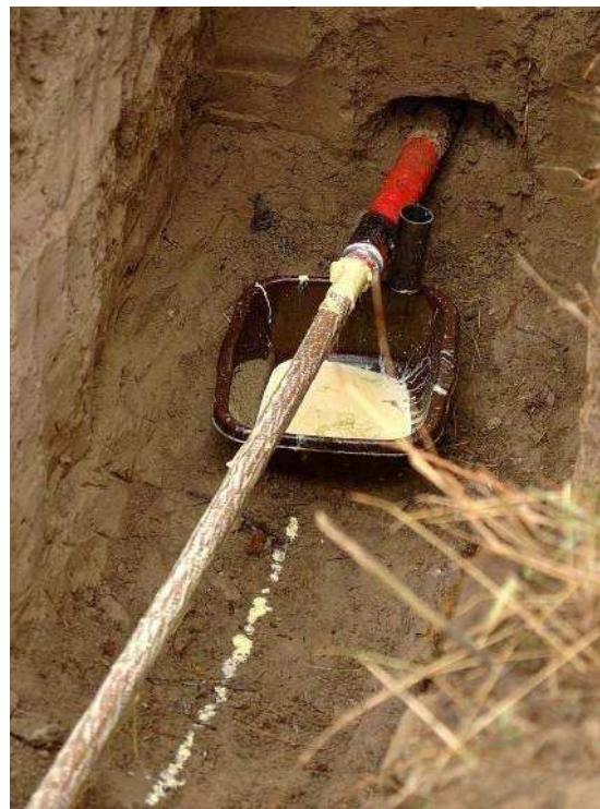
Рисунок 56: Процесс вытягивания сердцевины старого медножильного кабеля
